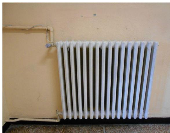
Figura 4.9 – Particolare di un radiatore in ghisa
